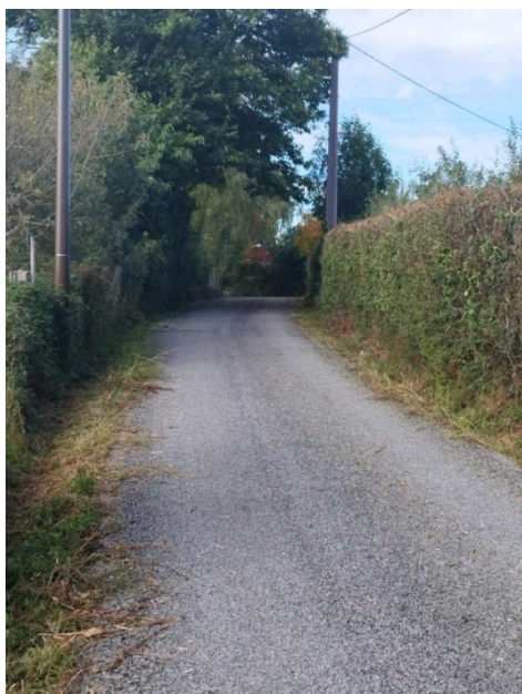
Réfection route (Coumiac)
