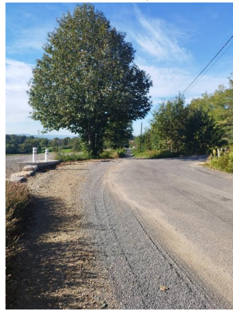
Réfection route (sortie pont de Salan)
